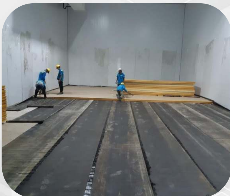
HÌNH ẢNH LẮP ĐẶT PANEL/ INSTALLATION IMAGES POLYURETHANE
