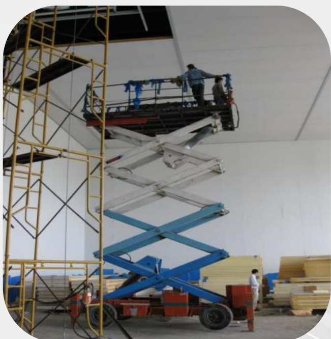
HÌNH ẢNH LẮP ĐẶT PANEL/ INSTALLATION IMAGES POLYURETHANE
