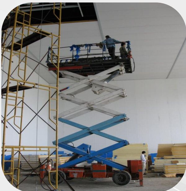
HÌNH ẢNH LẮP ĐẶT PANEL/ INSTALLATION IMAGES POLYURETHANE
